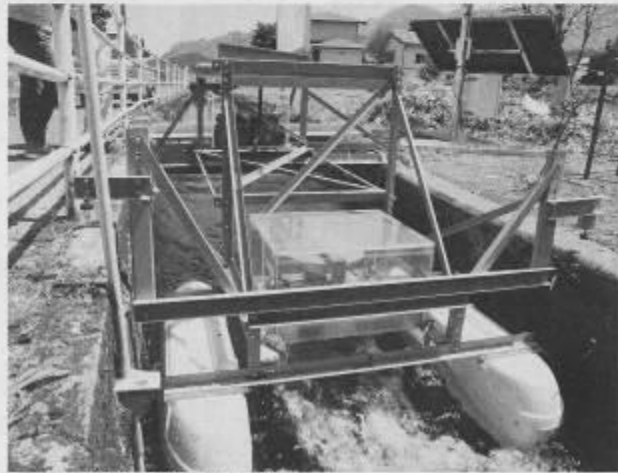
フワッター水力発電装置 (熊本県南阿蘇村で)
