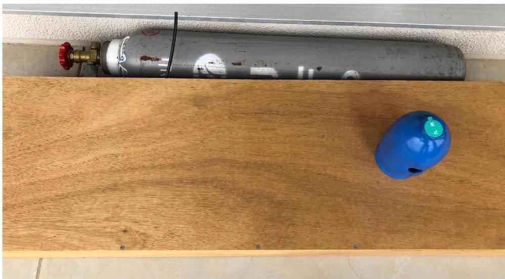
図 2.12 メタンガスポンベの保護容器
