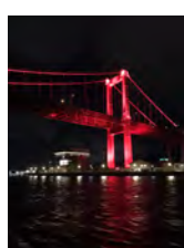
夜景クルーズ若戸大橋
