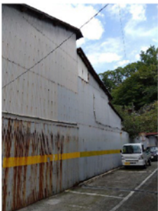
町家の壁面に張られたトタン
