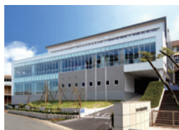
附属城東高校1号館外観
