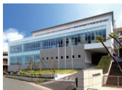
附属城東高校1号館外観
