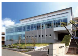
附属城東高校1号館外観
