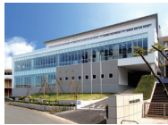
附属城東高校1号館外観
