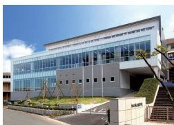
附属城東高校1号館外観
