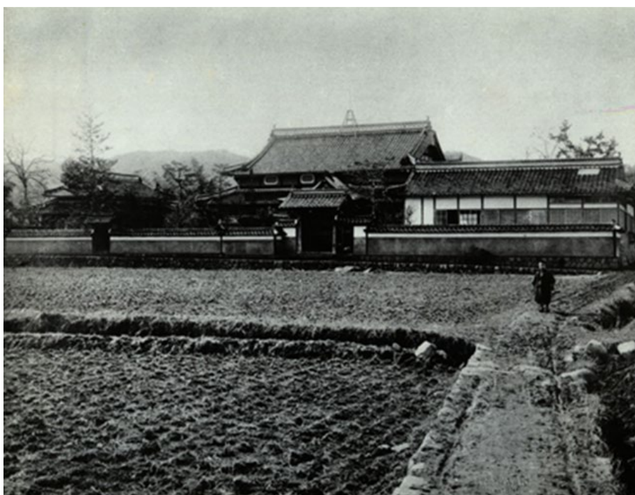
写真 5 大正 15 年（1928 年）ころの下川立の荒瀬旧宅。写真に写っている人は 5-6 歳の荒瀬秀隆と思われる。屋根の頂上の構造物は避雷針である。右の白い壁の建物が病院として使われていた。
